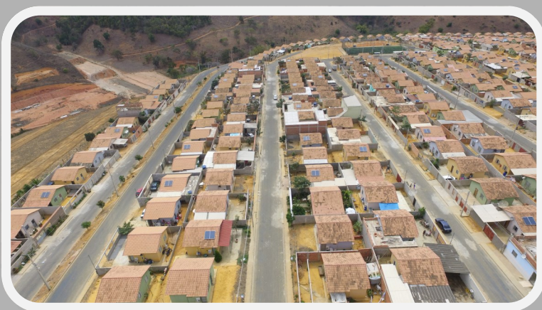
Vista aérea dos kits de geração de energia solar instalados
